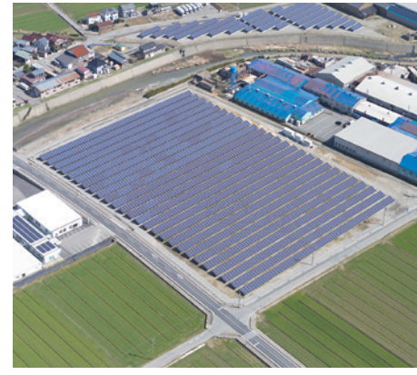
マルツ春江太陽光発電所 (福井県坂井市) 自社発電 敷地面積: 23,220㎡ 最大出力: 1,820kW 運転開始: 2015年2月20日
