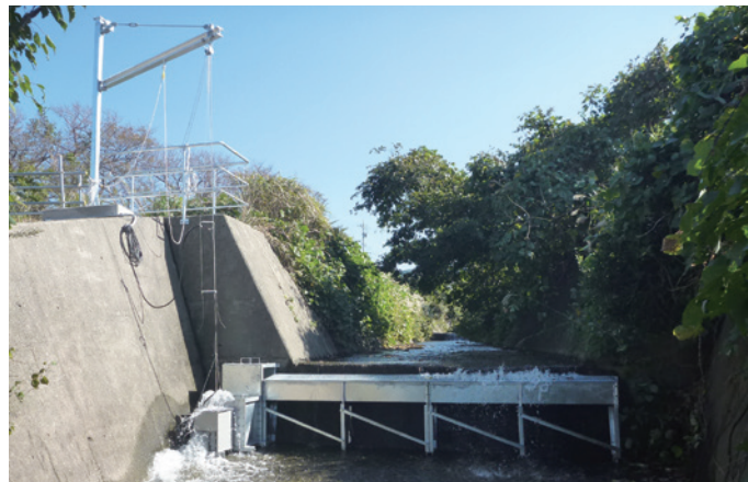
鷹巣マルツマイクロ水力発電所 (福井県福井市) 最大出力: 0.1kW 運転開始: 2014年11月4日
