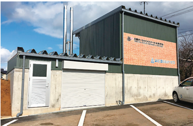
三国オーシャンリゾート&ホテル (福井県坂井市) 使用燃料: 県産間伐未利用材の切削/チップサイロ容量/方式 70m/半地下式 最大出力: 240kW 運転開始: 2015年12月14日
