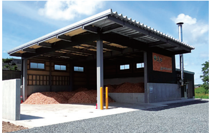
芦原国際ホテル美松 (福井県あわら市) 使用燃料: 県産間伐未利用材と製材端材の切削/チップサイロ容量/方式 150m/地上式 最大出力: 600kW 運転開始: 2016年5月17日
