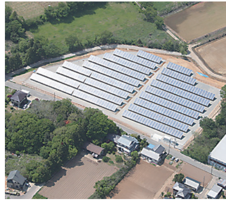
マルツ三国鐘場太陽光発電所 (福井県坂井市) 自社発電 敷地面積: 11,781㎡ 最大出力: 609kW 運転開始: 2013年3月28日
