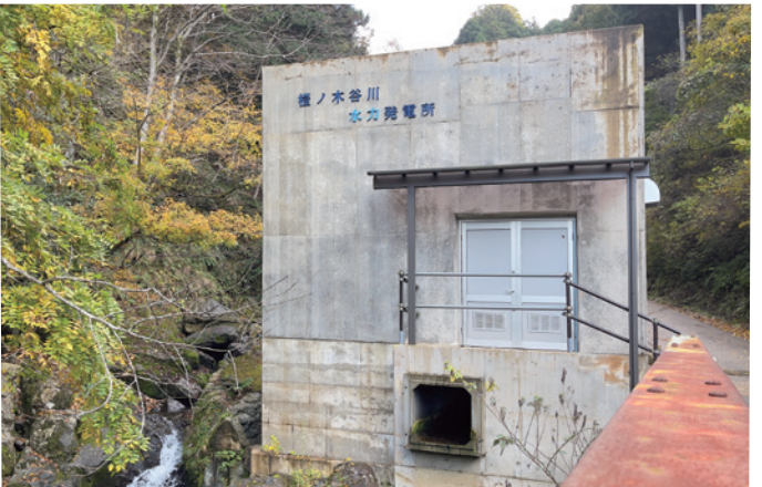
椋ノ木谷川小水力発電所 (福井県坂井市) 流量: 0.24m 3 /s 有効落差: 103m 最大出力: 199.3kW 運転開始: 2020年2月20日
