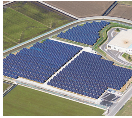
さかい太陽光発電所 (福井県坂井市) 自社発電 敷地面積: 18,116㎡ 最大出力: 1,176kW 運転開始: 2013年10月18日
