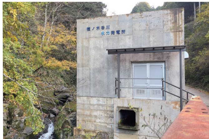
椋ノ木谷川小水力発電所 (福井県坂井市)
