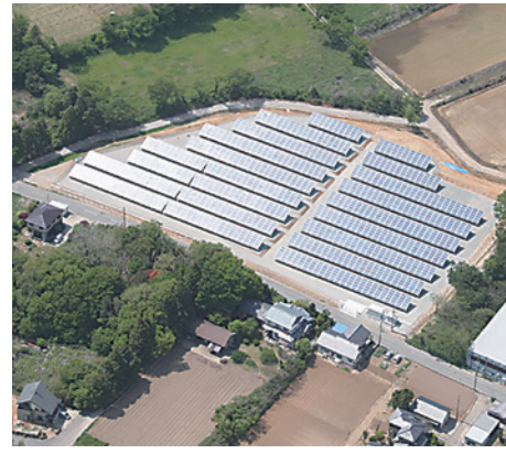
マルツ三国鐘場太陽光発電所 (福井県坂井市) 自社発電 敷地面積: 11,781㎡ 最大出力: 609kW 運転開始: 2013年3月28日
